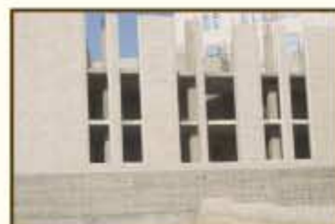
مبنى المجموعة رقم (٣) تحت الإنشاء منذ ٢٠٠٥/١/٥
