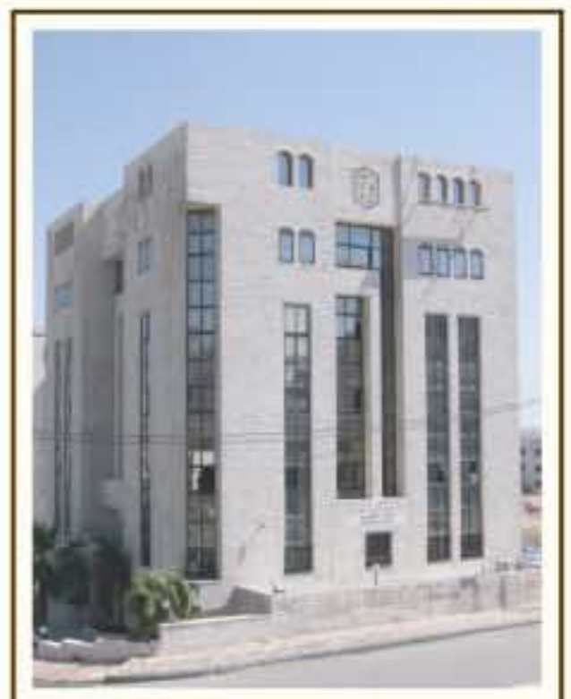
المبنى الإقليمي للمجموعة
