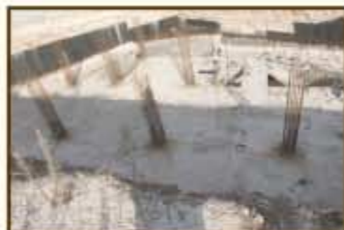
مبنى المجموعة رقم (٤) تحت الإنشاء منذ ٢٠٠٥/١/٥
